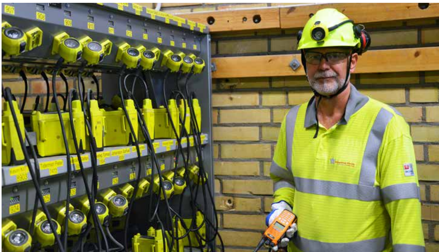
Per-Åke Persson bland lampor och PED-system. Snart kommer nya hyllor med laddstationer till de nya lamporna.
